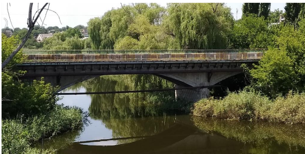
Рисунок 1 — Фасад мосту через р. Саксагань
