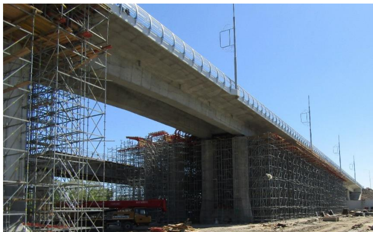
Рисунок 1 — Загальний вигляд прогонової будови моста на стадії будівництва [5]
