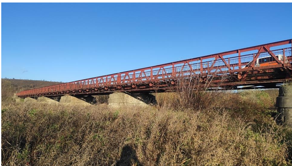
Рисунок 3 — Вид на малі ферми з паралельними поясами
